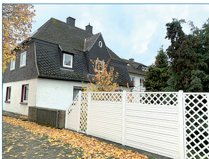
Einfamilienwohnhaus in 97653 Bischofsheim/Rhön 144 m 2 WFL, 6 Zimmer, 245 m 2 Grund, Garten, zentrale Lage, moderne Gastherme. Verbrauchsausweis F, 183,7 kWh/m 2 , Gas, BJ 1920 KP 125.000,-- €
