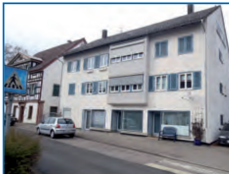
Oberndorf-Aistaig (0874) Großzügiges 6-Familienhaus in zentraler Lage, rd. 400 m 2 WFL, 2 Stellplätze, renoviert, voll vermietet, sehr gepflegt. Bj. (EA) 1935, EA-B, Hgz. Öl, Strom, Gas, Steinkohle, 126,2 kWh/(m 2 a). Kaufpreis 235.000,-- EUR *)
